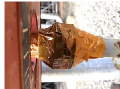
调压阀 的连接处 检测泄漏!!
