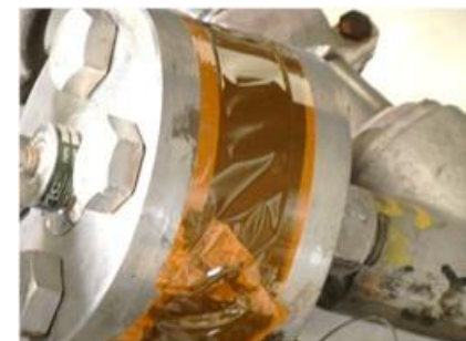
法兰部 检测泄漏！
